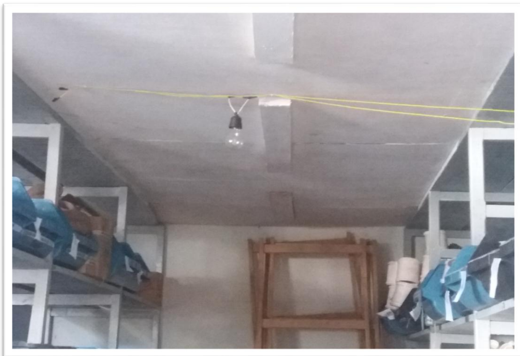
Figura 2-FIAÇÃO EXPOSTA
