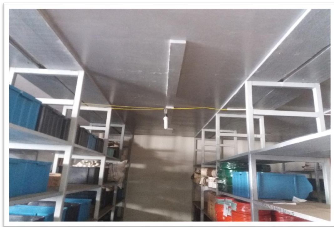
Figura 2-FIAÇÃO EXPOSTA
